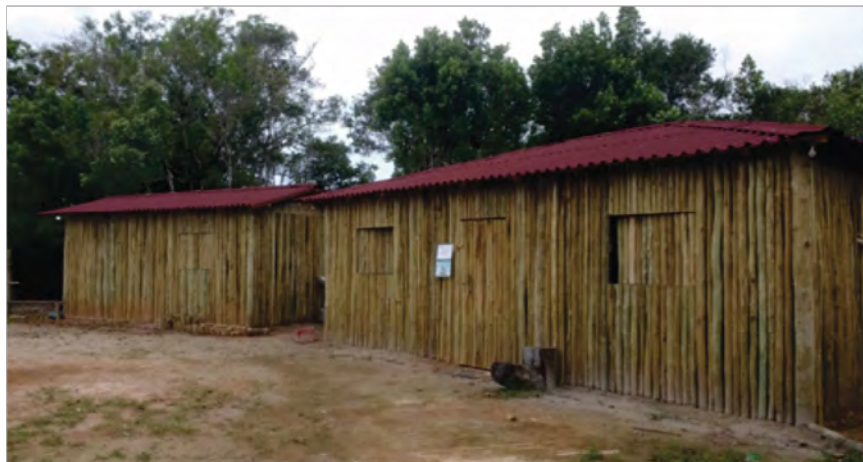
FIGURA 03: Casa grande e cozinha do espaço tradicional indígena para recebimento de turistas em atividades de TBC, construídas na aldeia Tabaçú rekoypi, Peruíbe/SP. Foto de propriedade dos autores.
